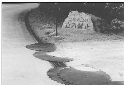
図 5 丸鋸の廃物利用（側溝の上に置いてある）
